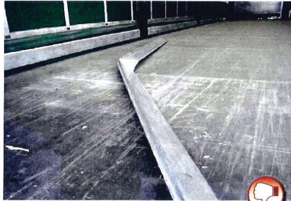
Alu-drop-in slats Bent drop-in slats
